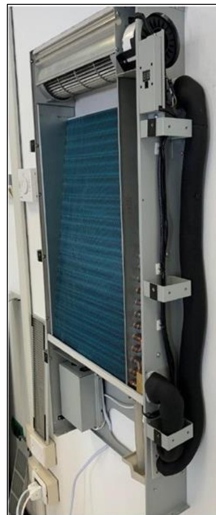
Szigetelje a csöveket a képen látható módon
